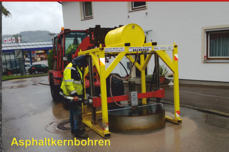
Ausbauen des Bohrkerns
